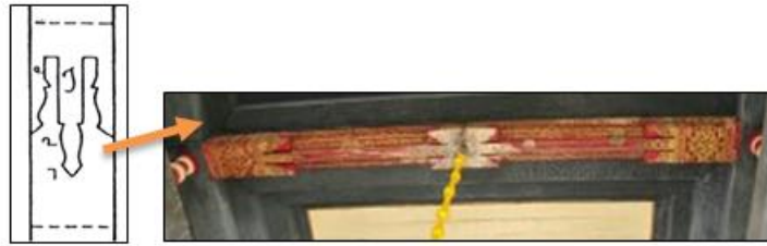
Figur 16. Balok Tengah pada Bangsal Sri Manganti (Sumber: Joglo: Arsitektur Rumah Tradisional Jawa, 1993 dan Dokumen Pribadi, November 2016 )
