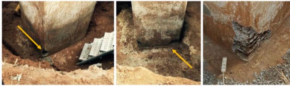
Gambar 2 Keropos pada Pilar P0
