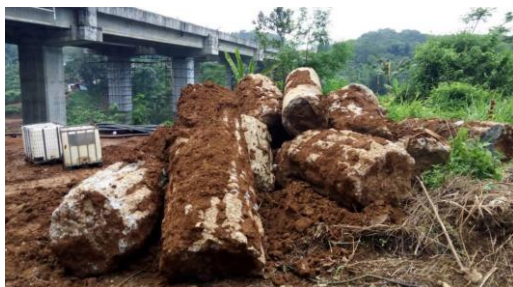
a. Ex-tiang Bor Pondasi pada Area Galian
