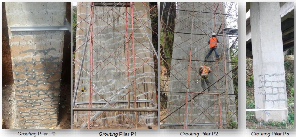
Gambar 5 Pekerjaan Grouting
