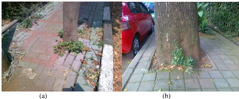
Gambar 5 Susunan Blok Beton yang Tidak Diberi Blok Pembatas (a) dan yang Diberi Blok Pembatas (b)
