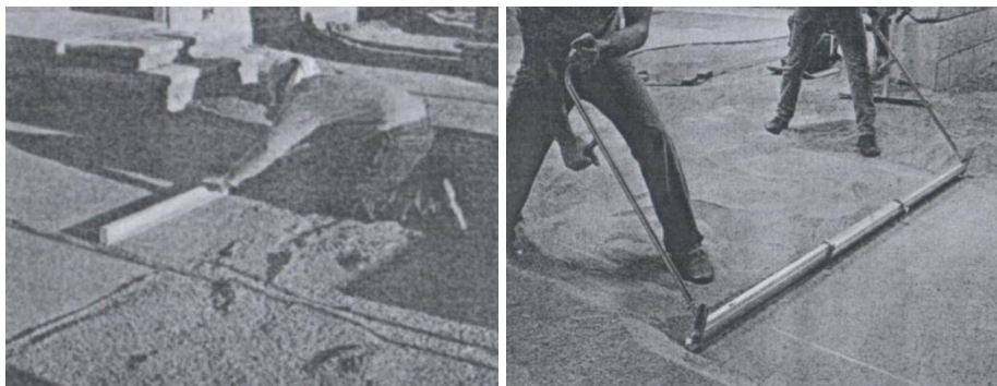
Gambar 9 Perataan Lapisan Pasir Menggunakan Perata oleh Satu dan Dua Orang (Hopper, 2010)
