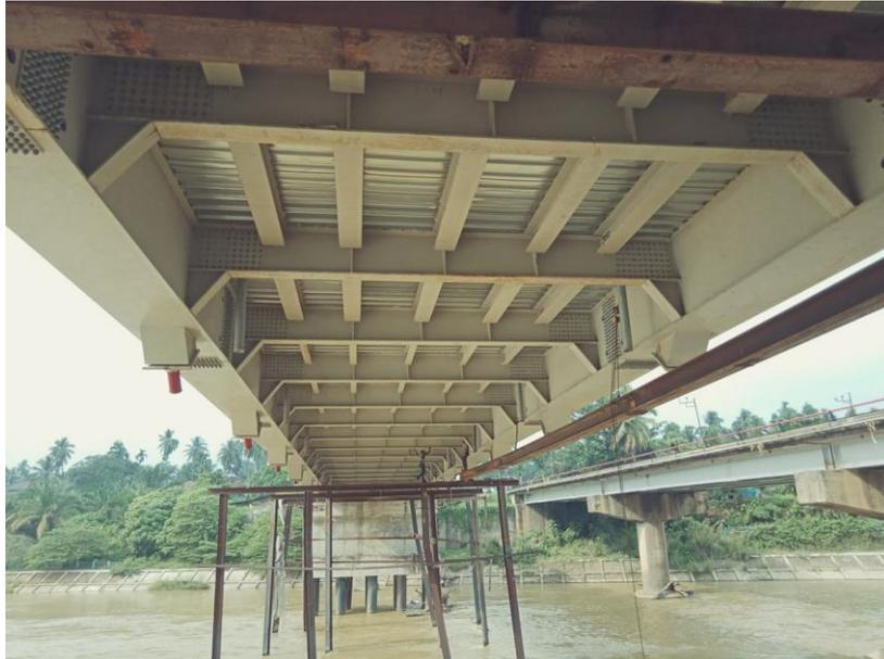
Keterangan: Dek terbuat dari *box girder* pada *main girder* kanan-kirinya, dengan *cross girder* profil I, tampak angkur *cable stayed* berwarna merah.
