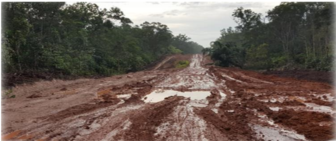
Gambar 1 Kondisi Eksisting Tanah Dasar Km 138+400
