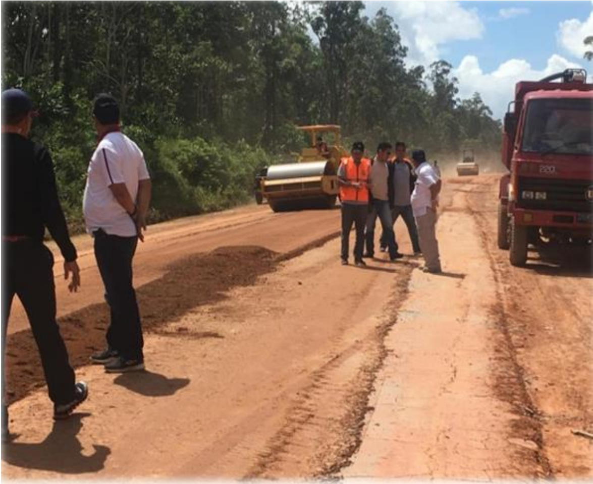
Gambar 5 Pelaksanaan Pekerjaan Lapis Fondasi Semen Komposit Tanah pada KM 138+200
