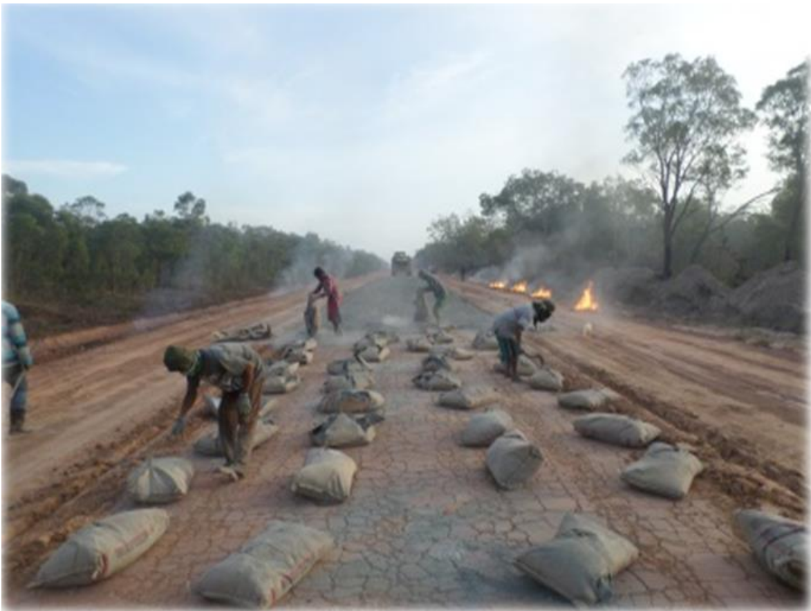
Gambar 3 Pelaksanaan Pekerjaan Lapis Fondasi Semen Komposit Tanah KM 138+400
