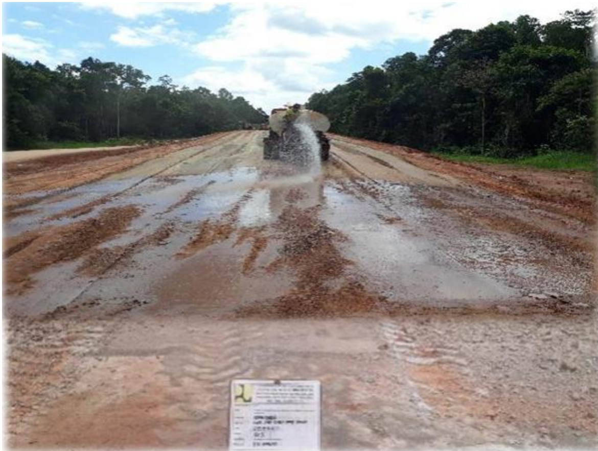
Gambar 4 Pelaksanaan Pekerjaan Lapis Fondasi Semen Komposit Tanah pada KM 399+450
