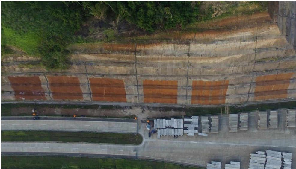
Gambar 3 Pemasangan Matras Cocomesh dan Coirblanket
