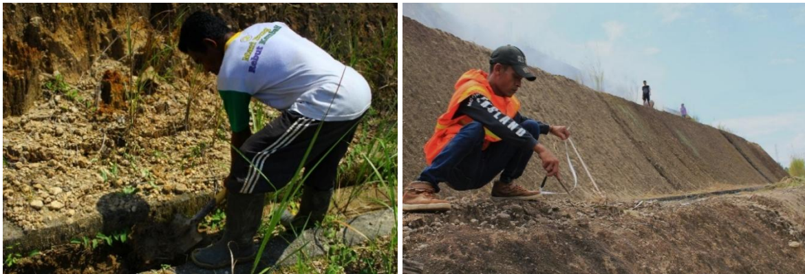
Gambar 2 Persiapan Lahan, Pematokan, dan Pembersihan Saluran
