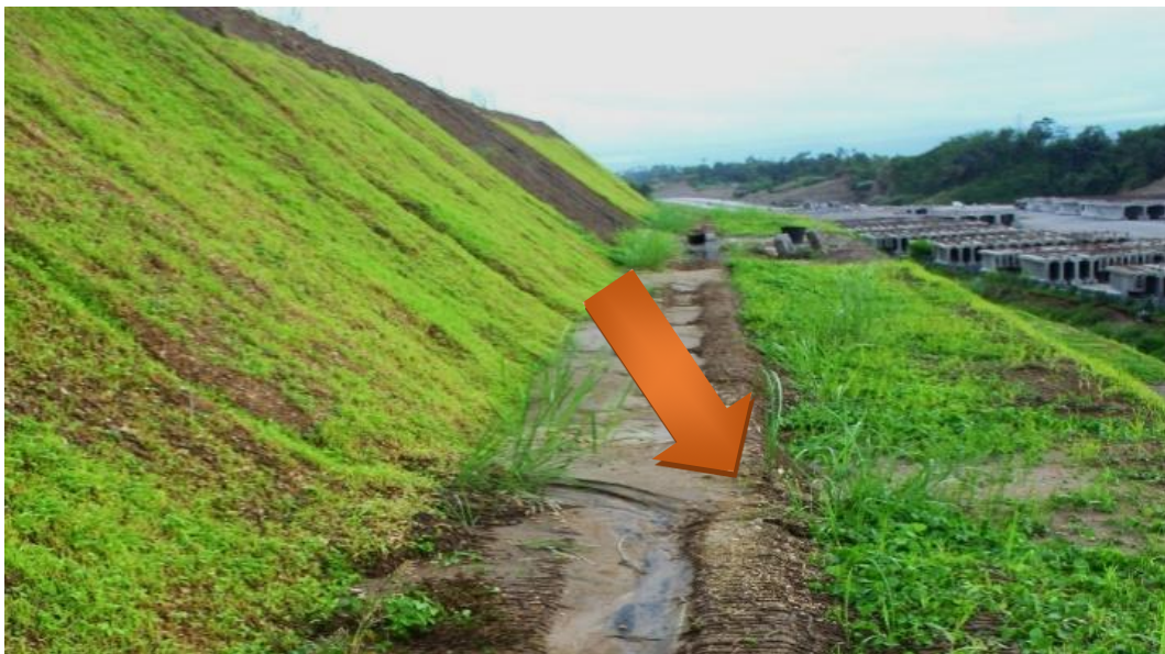
Gambar 8 Limpasan Erosi Permukaan dari Lereng yang Tidak Ditangani
