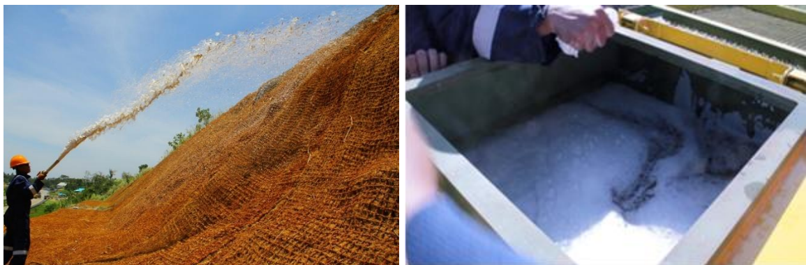
Gambar 4 Pencampuran dan Penyemprotan Material Hydroseeding
