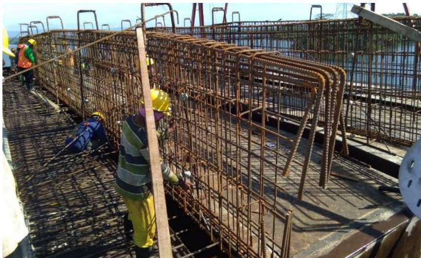
Gambar 11 Prefabrikasi Tulangan CBD
