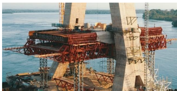
Gambar 2 Form Traveler Jembatan Pulau Balang
