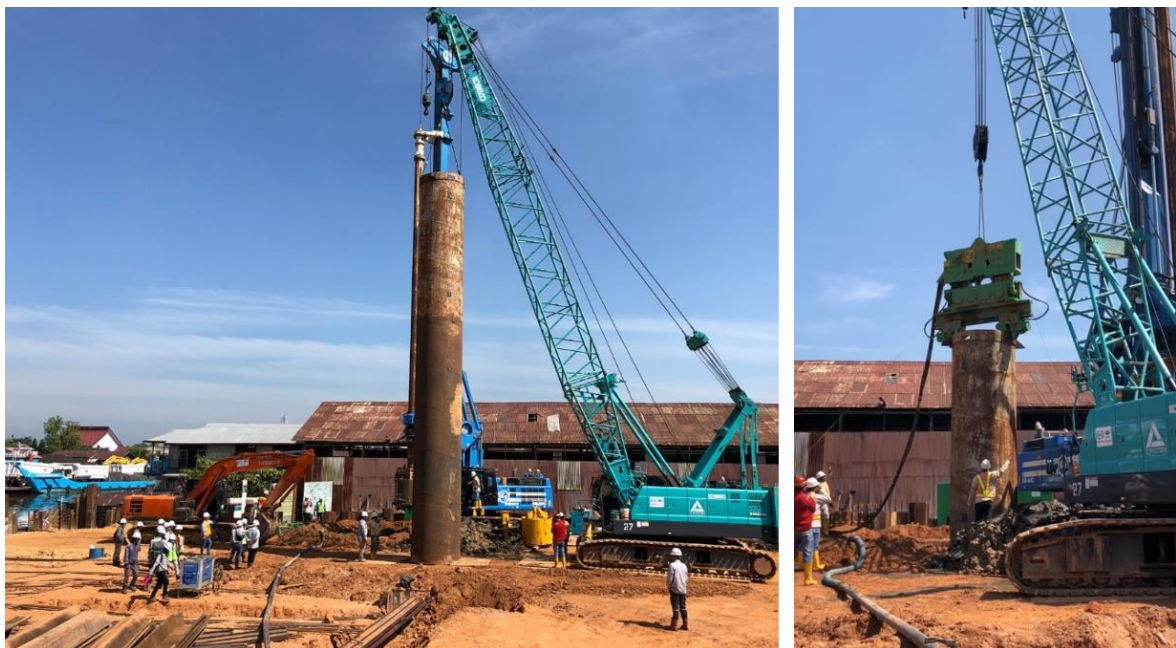
Gambar 9 Pemasangan dan Penarikan Selubung Sementara
