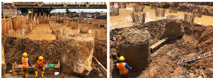
Gambar 15 Pengujian Pembebanan Lateral
