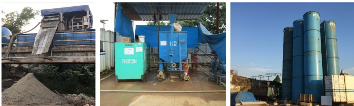
Gambar 8 Desanding pada Pekerjaan Tiang Bor
