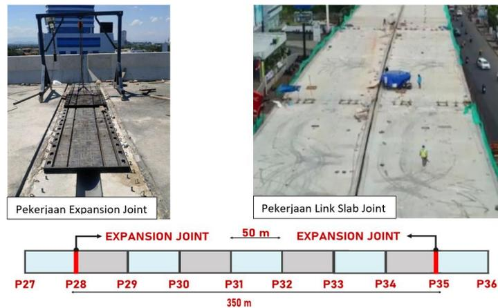
**Gambar 8** Diagram Lokasi Pemasangan Link Slab dan Expansion Joint
