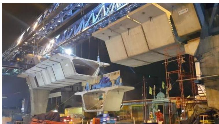
Gambar 6 Launching Gantry dengan Segmental Box Girder di Jalan Tol Layang Pettarani
