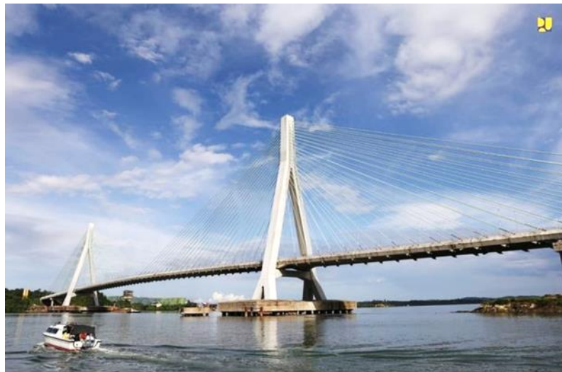
Gambar 10 Jembatan Pulau Balang
