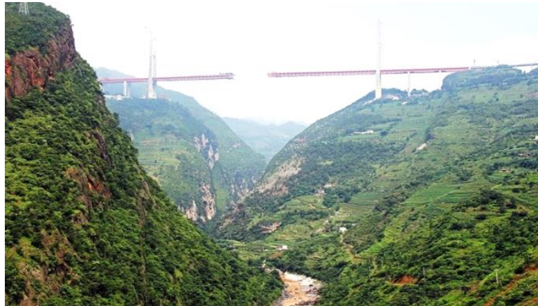
Gambar 8 Tower Penopang Penyanggah Jembatan
