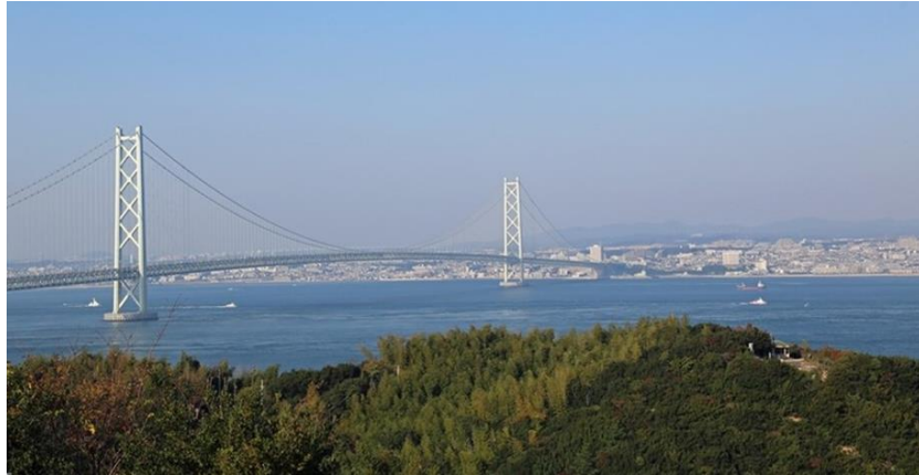
Gambar 2 Jembatan Gantung Akashi-Kaikyo
