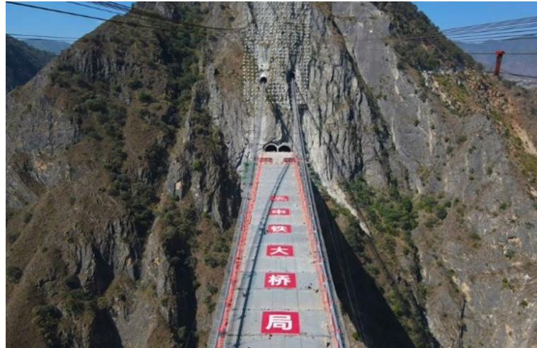
Gambar 6 Tampak Atas Lantai Jembatan Gantung Lvzhijiang
