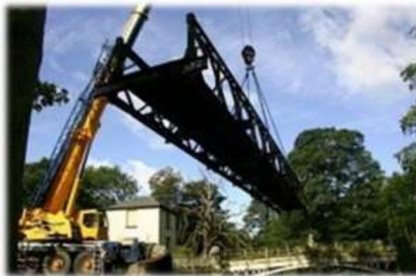
**Gambar 4** Erection Jembatan JPRB Metode Pengangkatan
