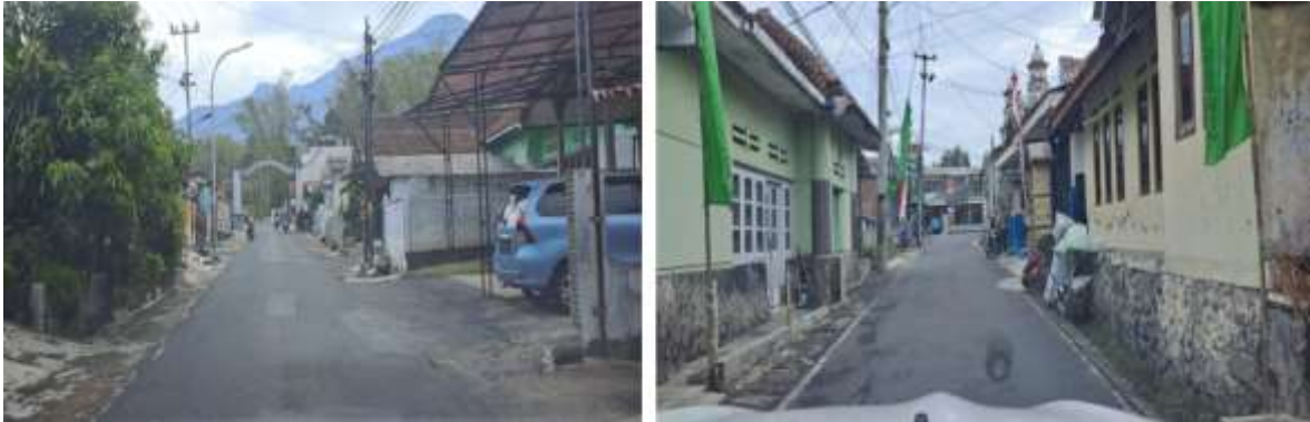
Gambar 6 Kondisi jalan kabupaten Jalaksana–Sidamulya
