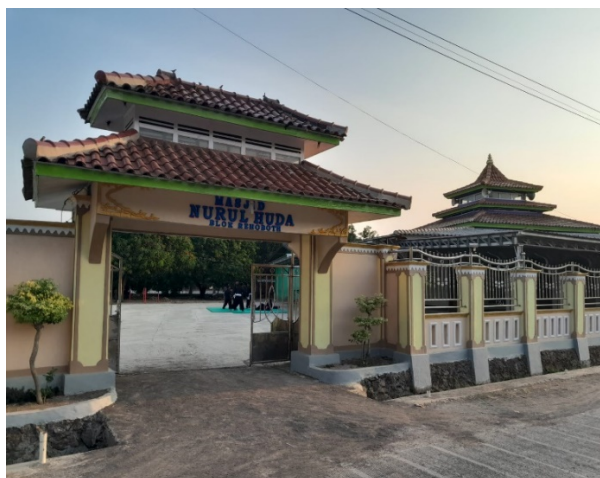
Gambar 3. Potret Masjid Nurul Huda Rehobot (Sumber: Dokumentasi Pribadi, 2023)
