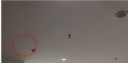
Gambar 8. Detektor Asap dan Pengeras Suara
