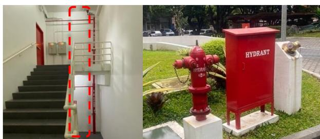
Gambar 4. Sistem pipa tegak dan sambungan pemadam kebakaran
