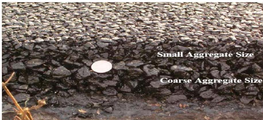
**Gambar 1** Susunan Lapis Atas dan Bawah pada Perkerasan Beraspal Porus Dwilapisan
