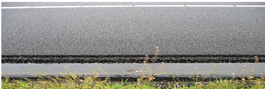
**Gambar 2** Konstruksi Perkerasan Beraspal Porus Dwilapisan
