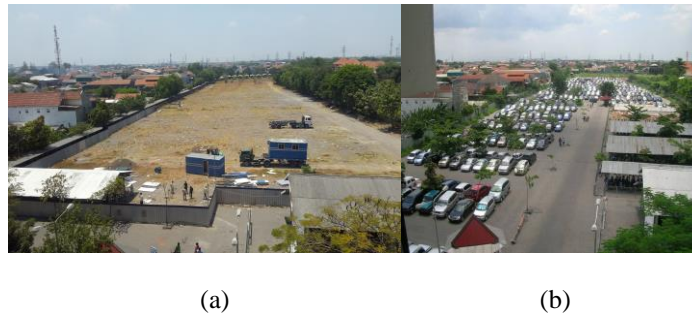
Gambar 1 Pembangunan Gedung P1 dan P2 dan Parkir Mobil pada Lahan Kampus Timur
