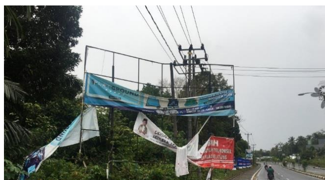
Gambar 4 Pembangunan Papan Reklame di Sisi Jalan Nasional Tanpa Izin
