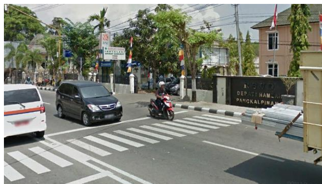
Gambar 3 Akses Langsung ke Jalan Nasional Tidak Berizin
