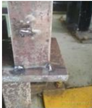
Gambar 9 Perakitan Konstruksi Tengah dan Konstruksi Atas
