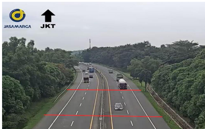
Gambar 2 Area Pengamatan pada Ruas Jalan Tol Cipularang KM 79
