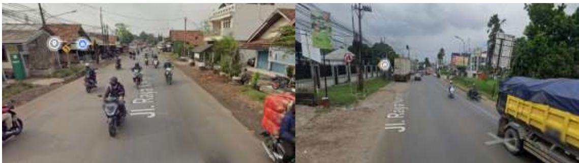
Gambar 3 Marka yang Pudar dan Rambu yang Tidak Terlihat Jelas
