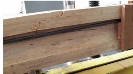
Gambar 9 Ragam Kegagalan Lentur Benda Uji 1 pada Flange dan Web.
