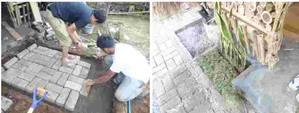
Pemasangan Batako sebagai jalur sirkulasi pada tapak dan penanaman tanaman (Sumber: dokumentasi pribadi)
