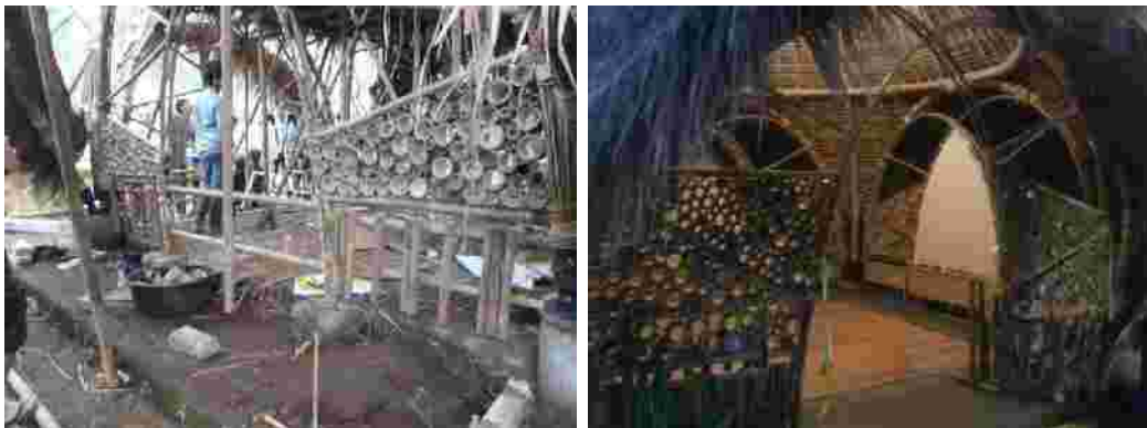
Pekerjaan Pemasangan roster fasade dan hasil akhir fasade (Sumber: dokumentasi pribadi)
