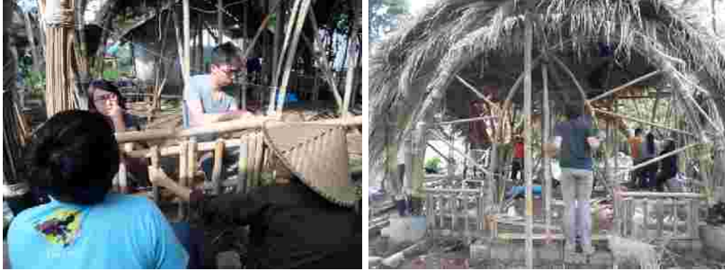
Pekerjaan Pemasangan rangka untuk (Sumber: dokumentasi pribadi)
