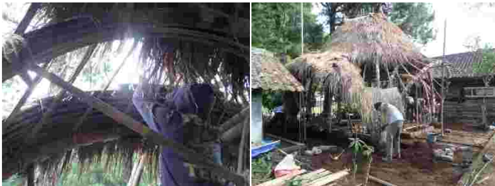
Pekerjaan Finishing Atap (Sumber: dokumentasi pribadi)
