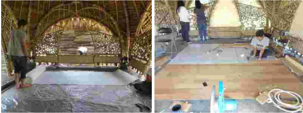
Pekerjaan pemasangan parquet kayu (Sumber: dokumentasi pribadi)
