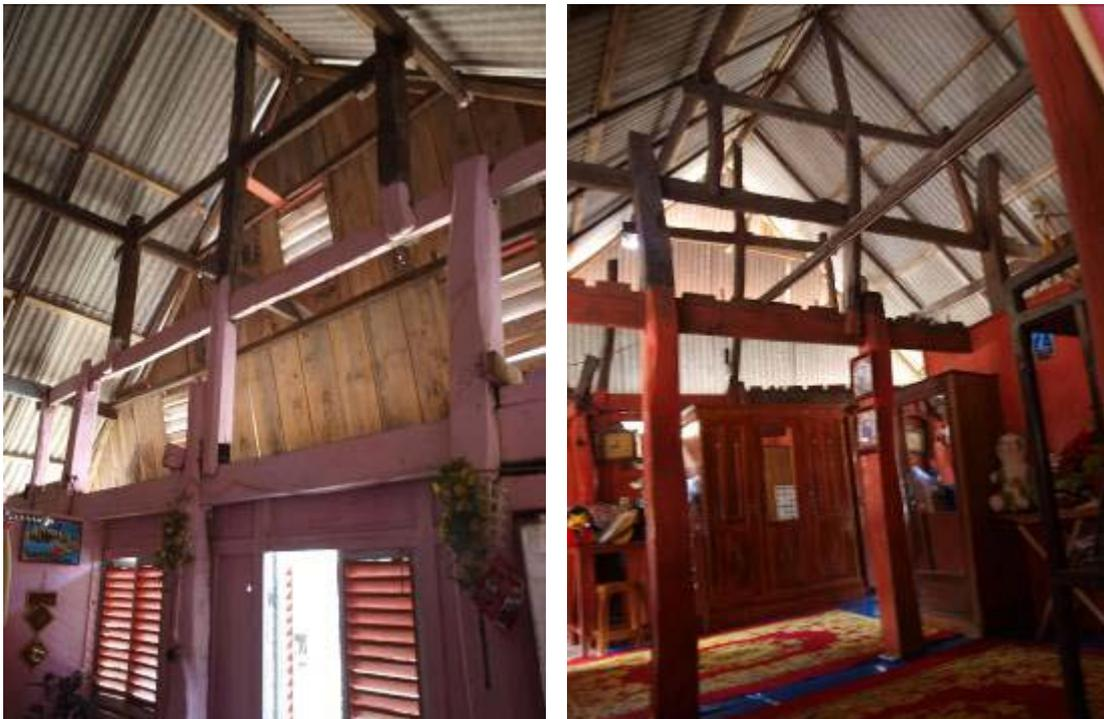
**Gambar 5.25.** (kiri) Struktur atap pada rumah Abdul Wahab dengan sistem konstruksinya yang tanpa paku/pasak, dan (kanan) Rangka plafong sebagai pengkaku struktur atap pada rumah Bapak Abdul Wahab.
