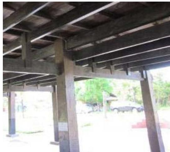
**Gambar 5.19.** (kiri) Rumah Bapak Abdul Wahab dan (kanan) Bola Soba yang memperlihatkan hubungan kolom dan balok pengikatnya (lubang dan pasak) yang terkait dengan cara membangun dan pembagian ruang secara horisontal.
