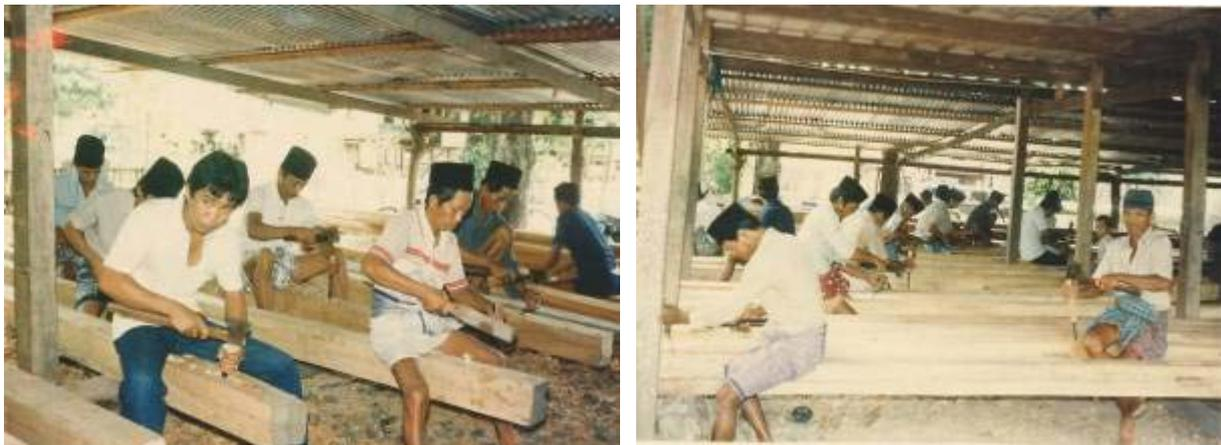
**Gambar 2.6.** Proses melubangi kolom.
