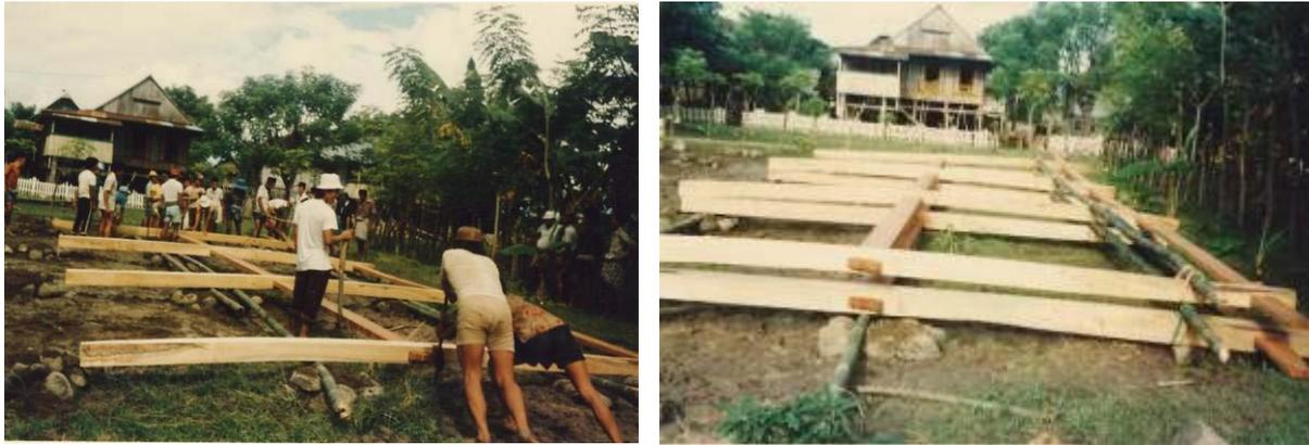
**Gambar 2.7.** Penyusunan kolom dan balok menjadi rangka rumah.
