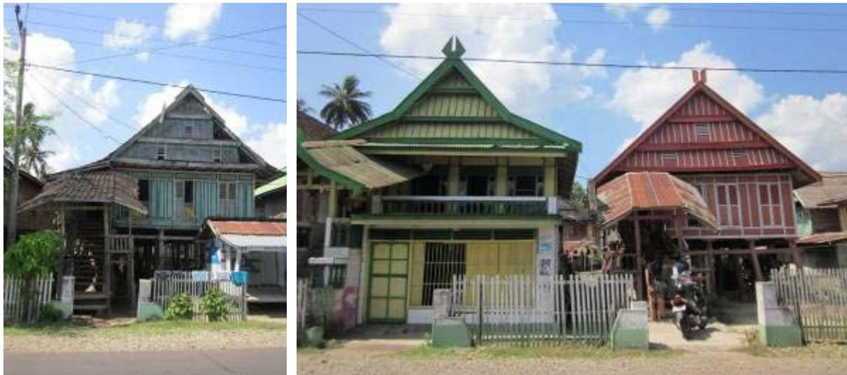
**Gambar 2.16.** Rumah yang dipilih adalah rumah yang paling kiri, rumah ini cukup tua, terlihat dari pengolahan material kayu yang minim; kolom-kolomnya tidak lurus.
