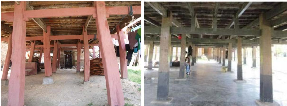
**Gambar 5.21.** Jarak antara balok lantai (arah panjang) dengan balok pengikat kolom (arah lebar).
