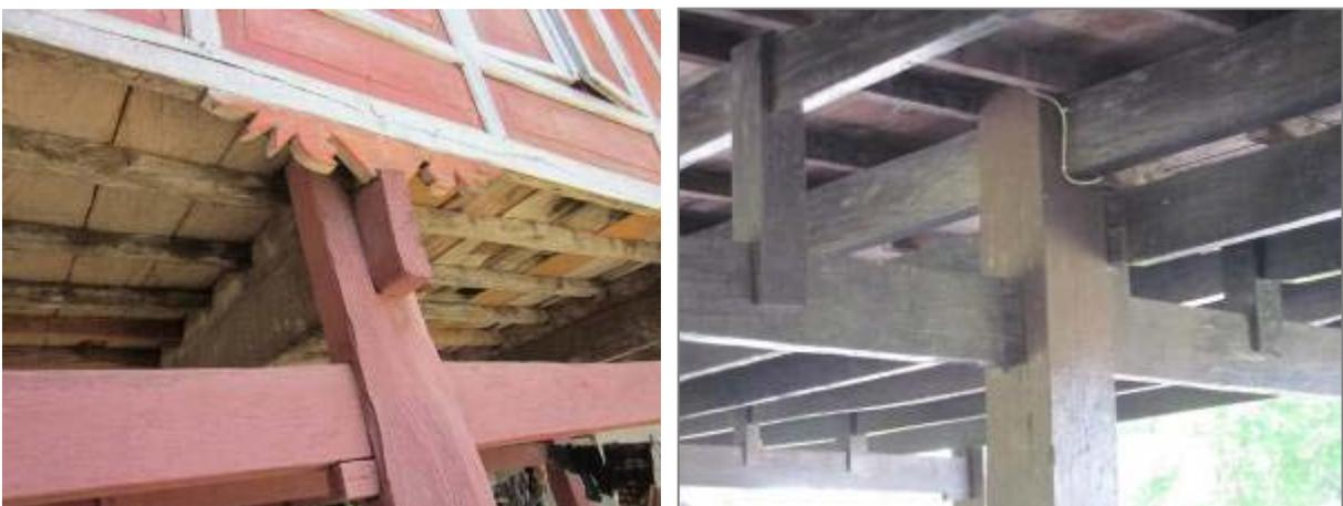
**Gambar 5.22.** (kiri) Kayu kecil di atas balok lantai pada rumah Bapak Abdul Wahab, (kanan) Balok-balok anak penyangga rangka lantai yang diikat ke balok pengikat kolom menggunakan kayu vertikal pada Bola Soba.
