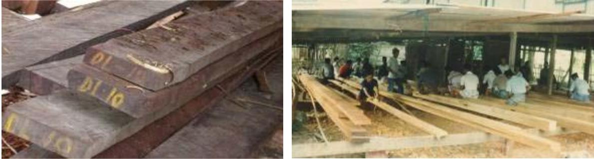
**Gambar 2.5.** Balok kayu yang sudah dipotong ditandai sesuai dengan penggunaannya pada arah panjang dan lebar bangunan(kiri), proses kayu penghalusan (kanan).
