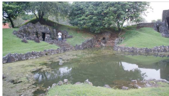
gambar 4.7 pintu air 2 (sumber: dokumentasi pribadi)
