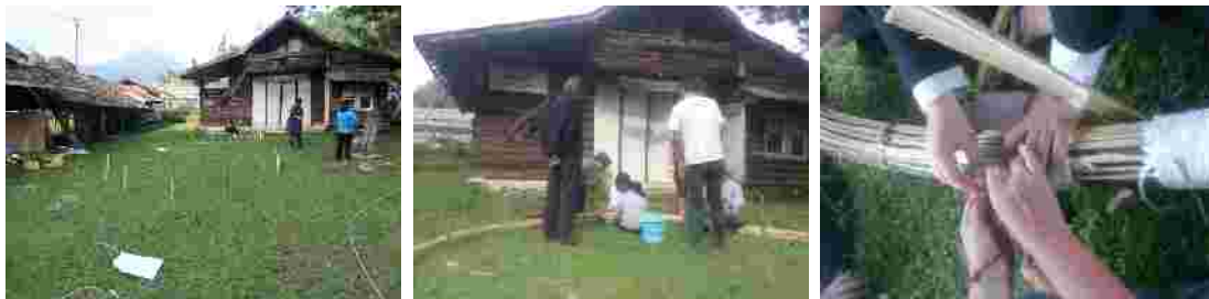
Pembuatan pasak, Penyusunan bambu bilah dan Pengikatan bambu bilah (Sumber: dokumentasi pribadi)
