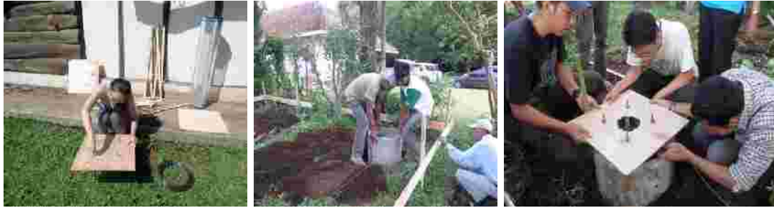
Pembuatan mal, pemasangan buis dan pemasangan tulangan bambu (Sumber: dokumentasi pribadi)
