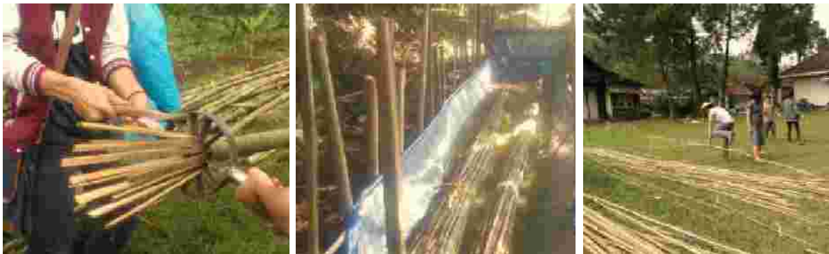
Pembilahan, pengawetan dan pengeringan bambu (Sumber: dokumentasi pribadi)
