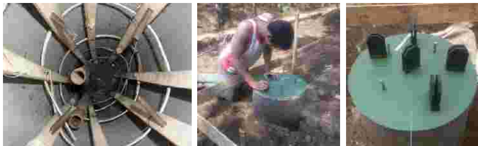
Tulangan bambu, pemasangan base plat dan kaki-kaki cawan (Sumber: dokumentasi pribadi)
