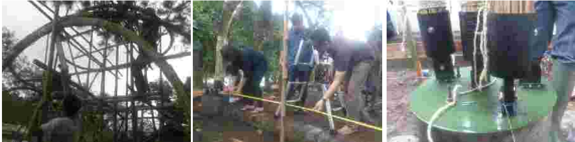
Pemasangan busur utama, Pengukuran ulang, Sambungan Cawan (Sumber: dokumentasi pribadi)
