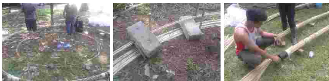
Pembuatan Ring, Penyusunan bilah bambu, Pemasangan Cawan pada Kaki Busur
