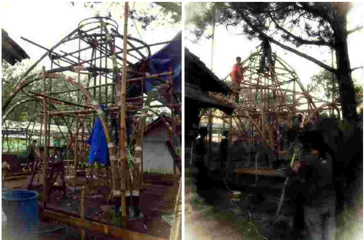
Hasil akhir tahap pembangunan pekerjaan struktur (Sumber: dokumentasi pribadi)
