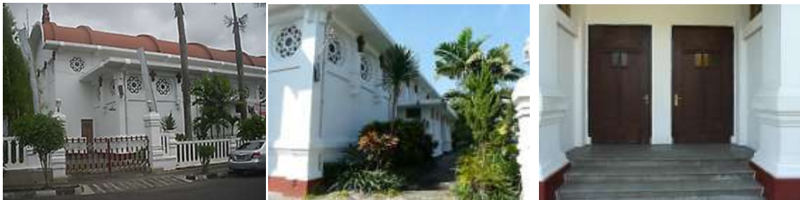
Gambar 5.4 Elemen-elemen fasad sisi Barat/muka
