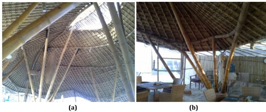
Gambar 3.4 Elemen struktural utama : bidang atap (a) dan kolom lurus - lengkung (b) sumber : dokumen pribadi
