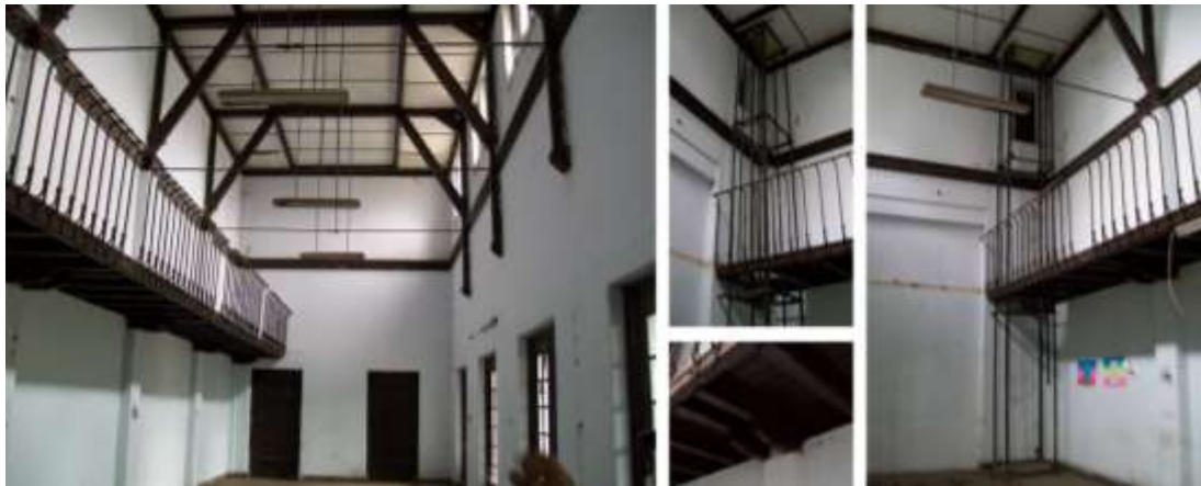
Gambar 18 Ruang konstruksi pada void dan cat-walk
