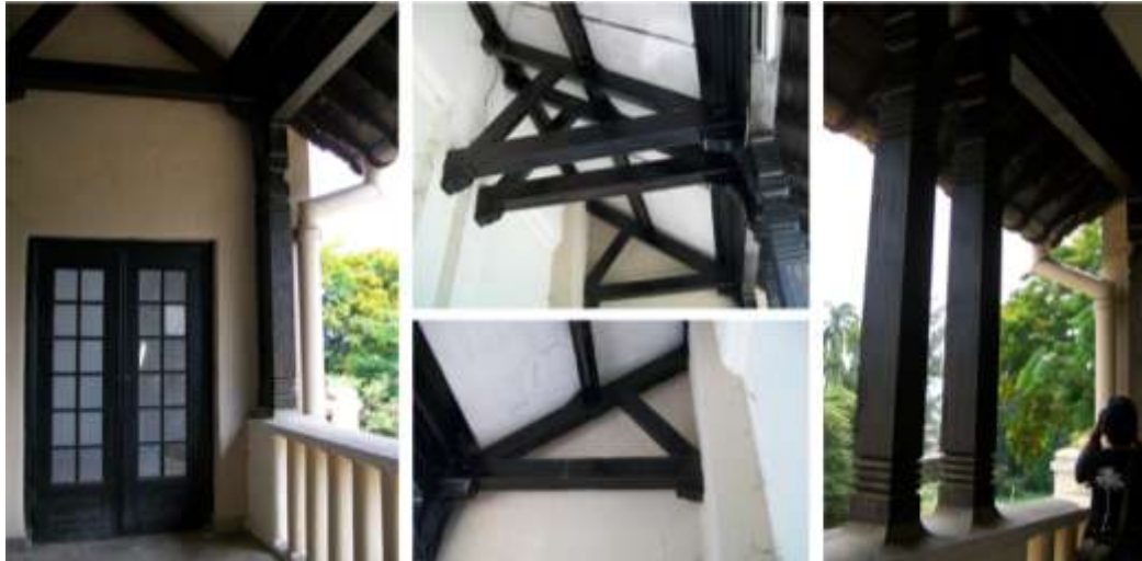
Gambar 17 Ruang konstruksi pada atap selasar
