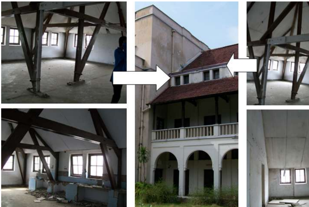
Gambar 16 Ruang konstruksi atap
