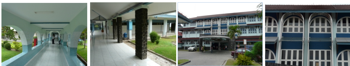
Gambar 7. Selasar lama dan Bangunan baru. Kiri: Struktur busur (selasar terpisah dari bangunan) diganti finishingnya. Kiri 2: Tiang (selasar bagian bangunan) asli disisakan 3 buah, lainnya diganti finishingnya. Tengah: Bangunan baru di bagian muka. Kanan: Pola lengkung jendela bangunan baru.
