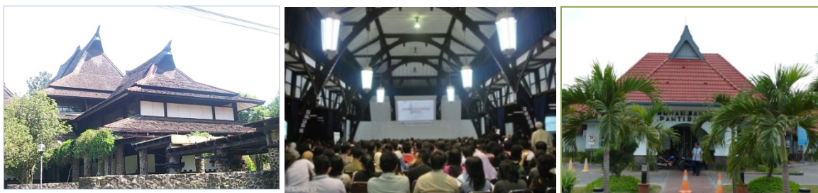
Gambar 1 : Sosok objek studi. Kiri: Tampak muka Aula Barat ITB. Tengah: Lengkung rangka busur kayu pada ruang dalam Aula Barat ITB. Kanan: Lengkung entrance muka bangunan administrasi RS. Panti Rapih.
