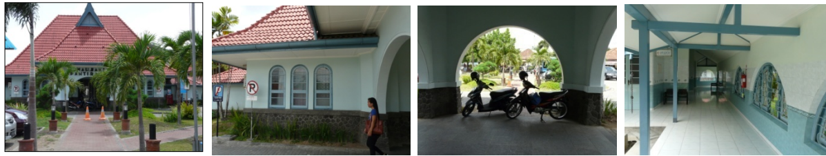
Gambar 10. Bentuk lengkung di RS. Panti Rapih. Kiri: Lengkungan pintu utama gedung administrasi. Kiri 2: Bentuk lengkung jendela gedung administrasi. Tengah: Lengkung pintu utama gedung administrasi (dari dalam). Bentuk lengkung jendela bangunan pada selasar
