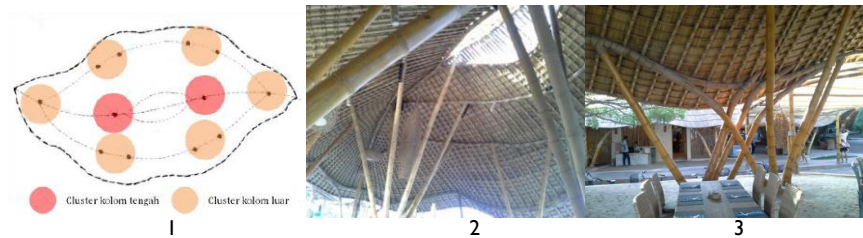
Gambar 4.8 Konfigurasi Elemen Struktur: Kolom Denah (1), Cluster Kolom Tengah (2), Cluster Kolom Tepi (3) Sumber : Maurina, Anastasia. Estetika Struktur Bambu Pearl Beach Lounge (2014)
