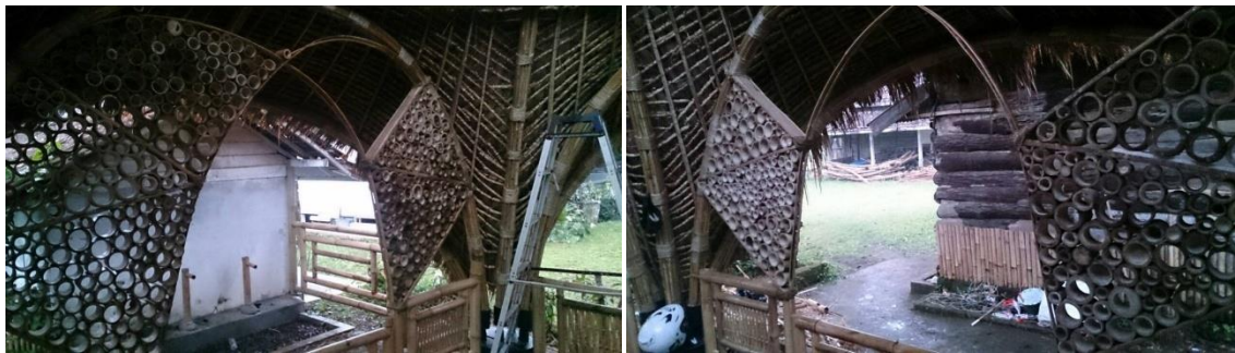
Perbaikan fasade rooster
