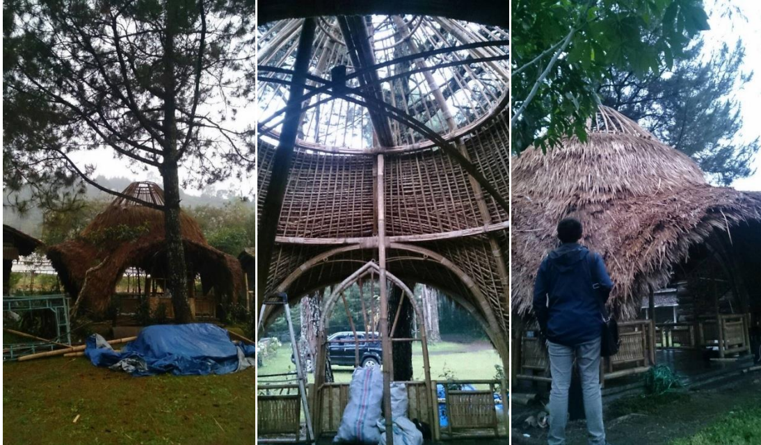
Proses Pemasangan Atap Alang-Alang
