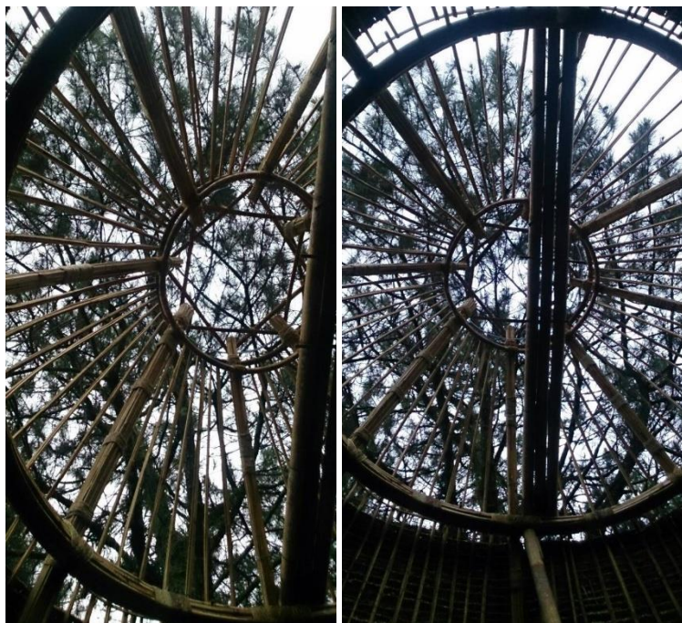
Perangkaian Kaso yang terbuat dari bilah bambu
