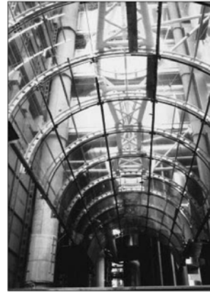
Gambar 8. Kanopi area masuk gedung Lloyds di London (lengkung struktur mengambil analogi pesawat) Sumber: MacDonald 2001
