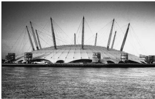
Gambar 9. Millenium Dome, London (struktur tarik form-active untuk bangunan berdimensi sangat luas) Sumber: MacDonald 2001
