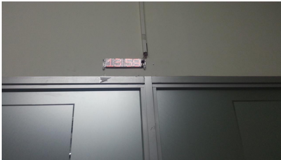
Gambar 7. Jam Digital yang dipasang di Lantai SB Gedung 9 (Lab Komputasi)
