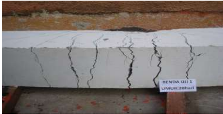
4.5 Pola Retak Akibat Uji Lentur Pada Balok Beton Bertulang 0%RCA
