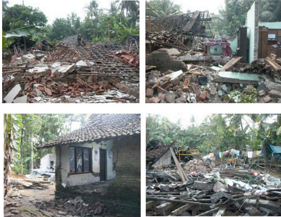
Gambar 3.9 Kondisi kerusakan permukiman RT 05 Desa Ngibikan sesaat setelah terjadi gempa
