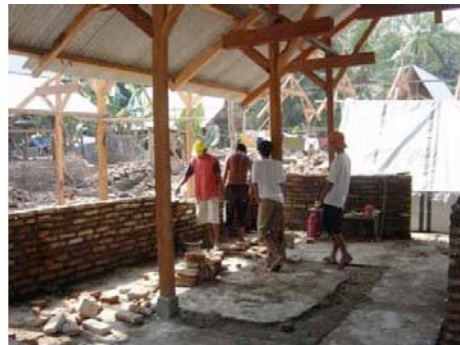
Gambar 4.33 Pemasangan atap -Pemasangan fibrecement gelombang -Pemasangan bubungan seng Sumber Dok : Eko Prawoto
