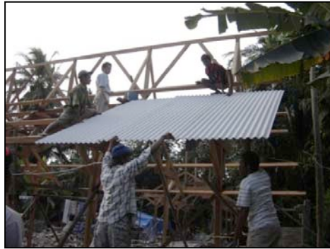
Gambar 4.33 Pemasangan atap -Pemasangan fibrecement gelombang -Pemasangan bubungan seng Sumber Dok : Eko Prawoto
