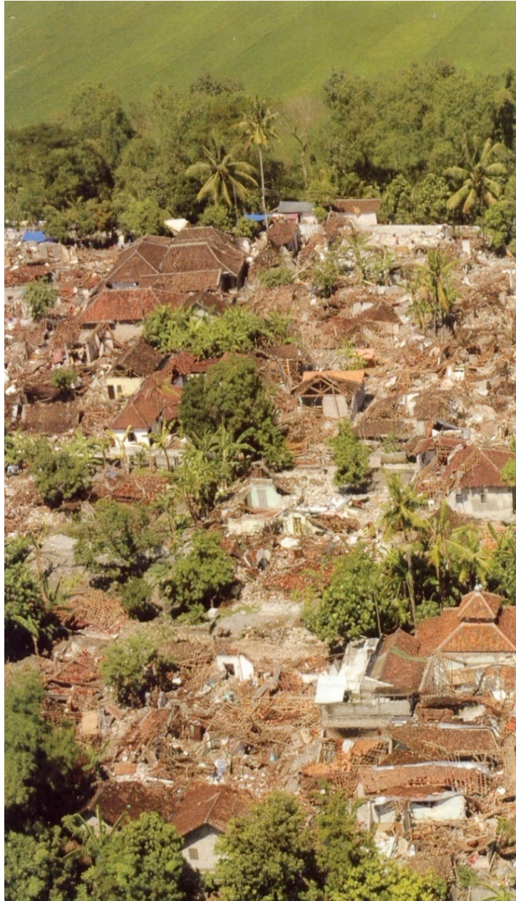
Gambar 3.6 Foto udara Permukiman Desa Ngibikan yang hancur akibat gempa.
