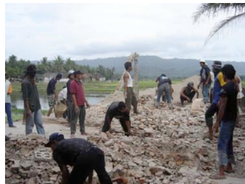
Gambar 4.19. Jenis Pekerjaan Proses Pengerjaan
