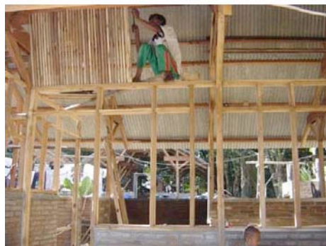
Gambar 4.36 -Pemasangan kisi –kisi lubang angin ventilasi Sumber Dok : Eko Prawoto
