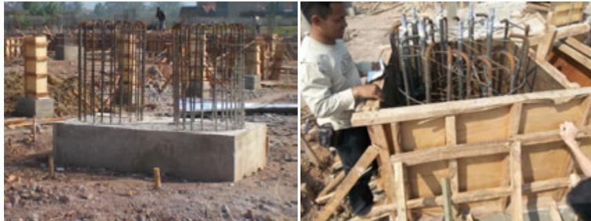
***Pembuatan pile cap dan tulangan pedestal beton (kiri)
