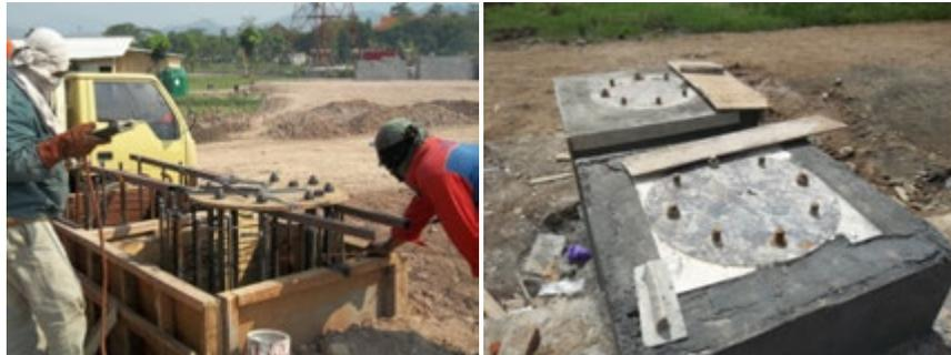
***Pemasangan angkur (kiri) dan Pengecoran pedestal (kanan)***
