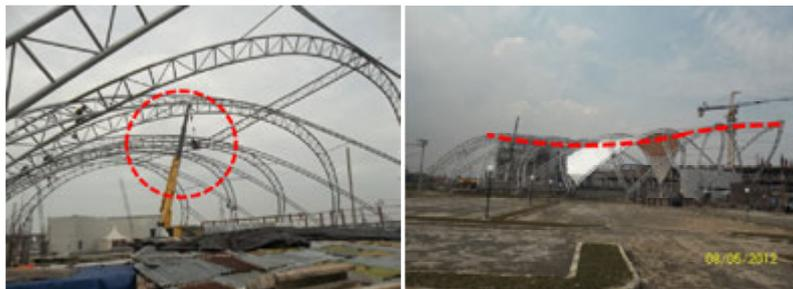
**"patah" pada truss pengikat (kiri) dan perubahan bentuk truss pengikat (kanan)**
