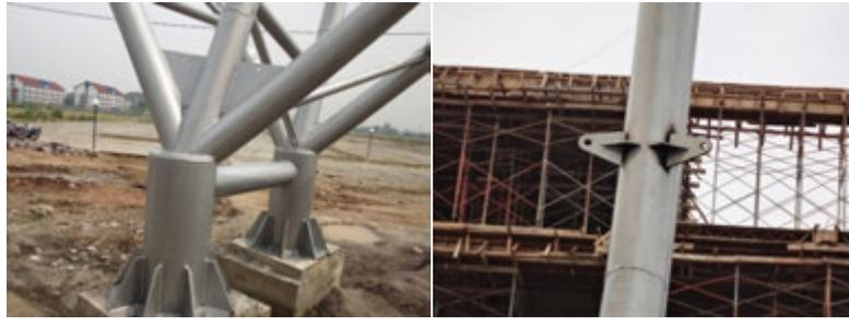
Plat yang dipasang pada tumpuan (kiri) dan Plat yang dipasang pada batang truss (kanan)
