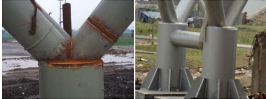
*Sambungan batang-batang utama busur-pipa vertikal (kiri) dan pipa horizontal (kanan)*
