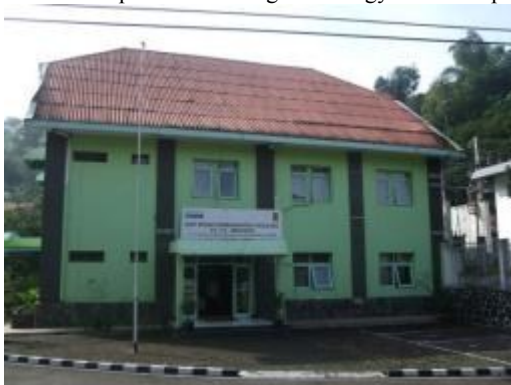
Gedung PLTA Bengkok
