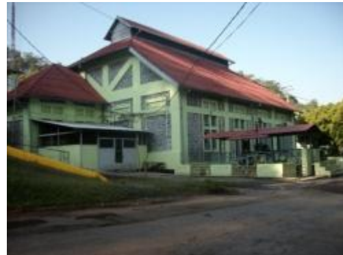
Gedung PLTA Bengkok
