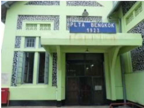
Gedung PLTA Bengkok
