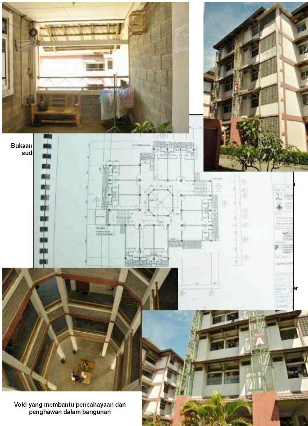
Gambar 4.14. Pencahayaan dan Penghawaan Rusunawa Cigugur Tengah, Cimahi (sumber: UPTD Rusunawa Cigugur Tengah & Dok.Pribadi)
