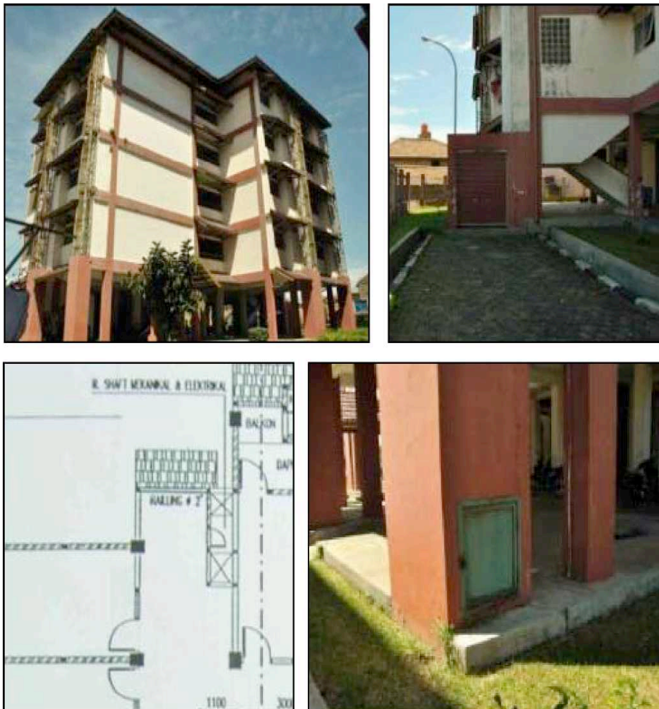
Gambar 4.15. Utilitas Rusunawa Cigugur Tengah, Cimahi (sumber: UPTD Rusunawa Cigugur Tengah)
