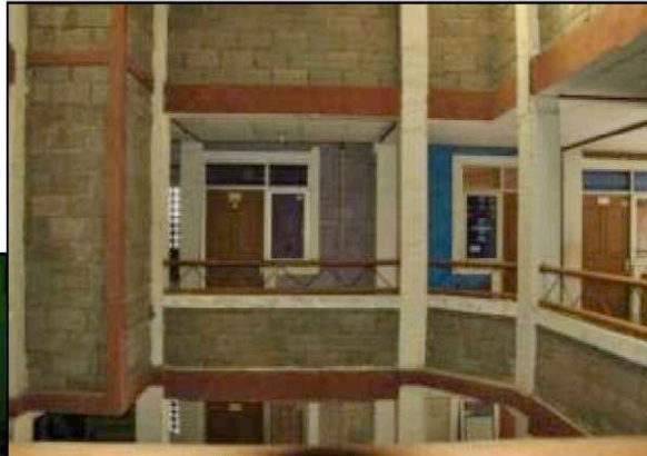
Jendela pada muka unit untuk pencahayaan dan penghawaan dari void
