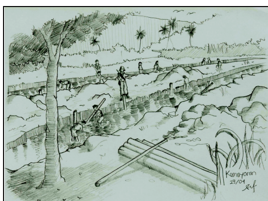
Gambar 38: Pembangunan jalan dengan meninggikan tanah dari bekas galian kanal di sisi jalan Sumber: www.google.com
