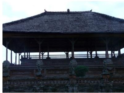
Gambar 10. Dinding alas bangunan Bale Kambang (utuh, bertanaman)
