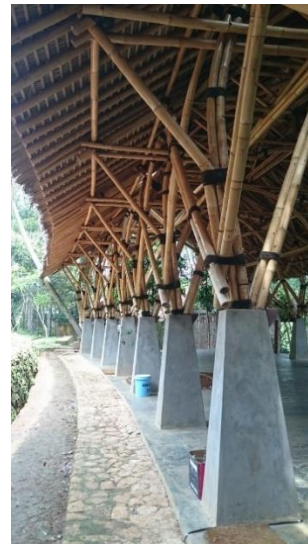
Gambar 12. Pondasi pada bangunan
