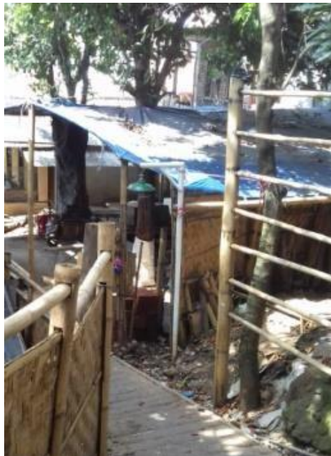
Figur 43. Atap dipasang pada saat lapangan digunakan untuk penyimpanan material pembangunan
