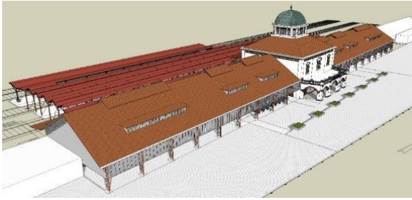
Figur 5. Aerial View Massa Bangunan Stasiun
