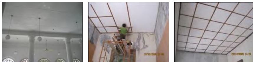
Figur7. Kondisi Eksisting – Pengerjaan – Kondisi Setelah Konservasi Plafond (Sumber: Dokumentasi PT Han Awal & Partners dan Pusat Dokumentasi Arsitektur)
