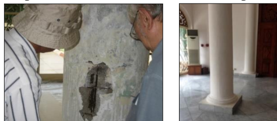
Figur11. Kondisi Eksisting Kolom Sebelum dan Sesudah Dikonservasi (Sumber: Dokumentasi Han Awal dan Dokumentasi Pribadi)
