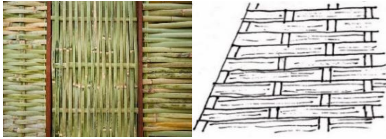
Figur 4. Dinding Anyaman Bambu Soe Ker Tie House dan Ilustrasi Sumber: www.archdaily.com dan dokumentasi pribadi
