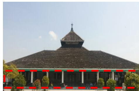
Barisan kolom yang mengelilingi serambi masjid membentuk fasad bangunan
