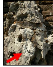
Gambar 34. Semen Pasir Menutup Batu Wadasan (Sumber: Dokumentasi Pribadi)
