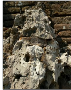
Gambar 38. Penggunaan Semen untuk Menempelkan Wadasan yang lepas
