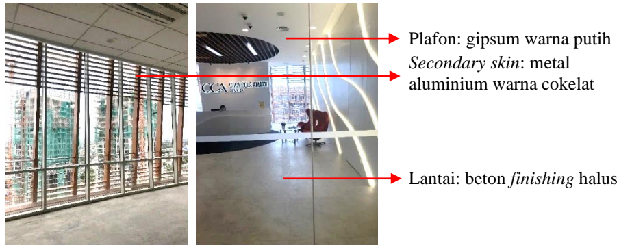
Gambar 10 Material Lantai, Secondary Skin , dan Plafon Eksisting (Sumber: Dokumentasi Pribadi)
