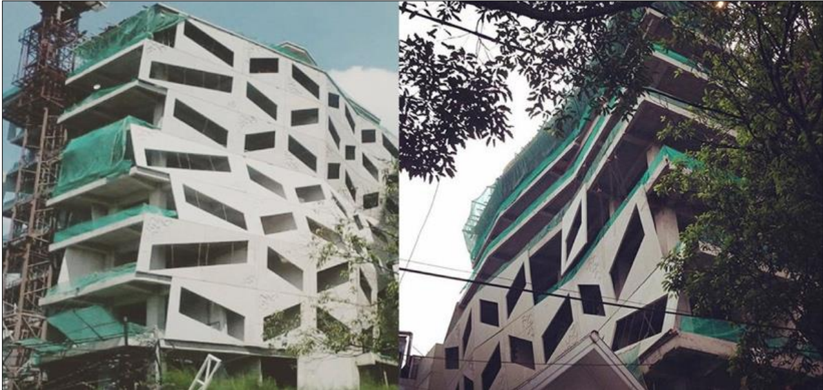
Figur 12. Objek saat dikonstruksikan
