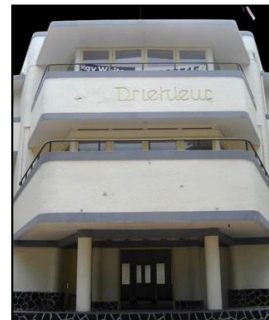
Gambar 45. Tampak Fasade Tahun 2020 Sumber : arsiendarcon konsultan bandung, Aziz Ramadani /MVoice
